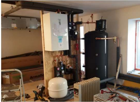
Wärmepumpe und Lüftungsanlage
