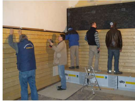
Einbau der Prallwände in Eigenleistung
